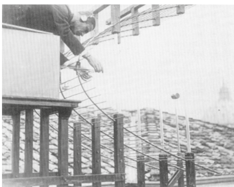
L'ingénieur MATHIEU procédant au réglage de l'antenne micro-ondes à Radio Vatican en 1932 (source : JACQUET, Ph., JACQUET-LADRIER, F., La vie à Namur au temps du roi Albert , p. 213).
